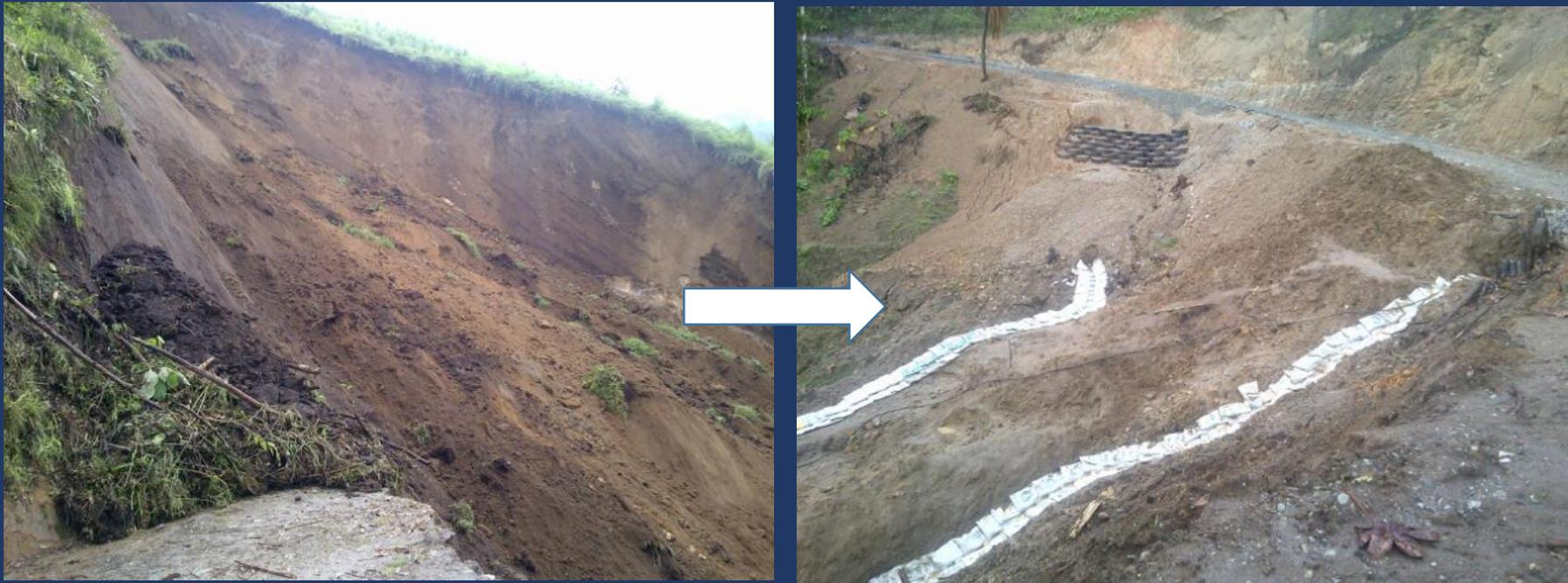
Por causa de la ola invernal del año 2013 se presentó un deslizamiento de gran magnitud sobre la vía La Albania obstruyendo el paso vehicular para realizar la extracción maderable; por ello, fue necesario hacer diferentes obras de ingeniería y contratar maquinarias para la remoción de la tierra y realizar ampliar la vía para el paso vehicular.
